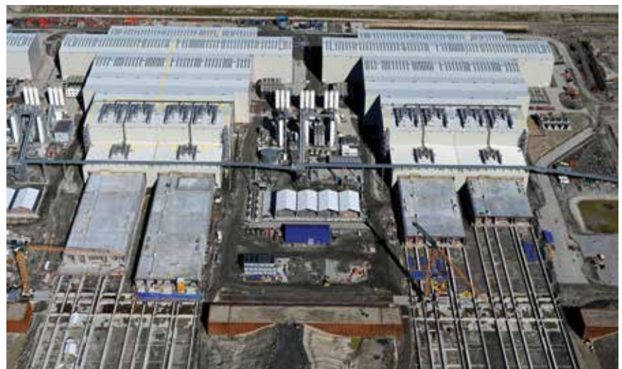
Pogon za proizvodnju tunelskih elemenata
