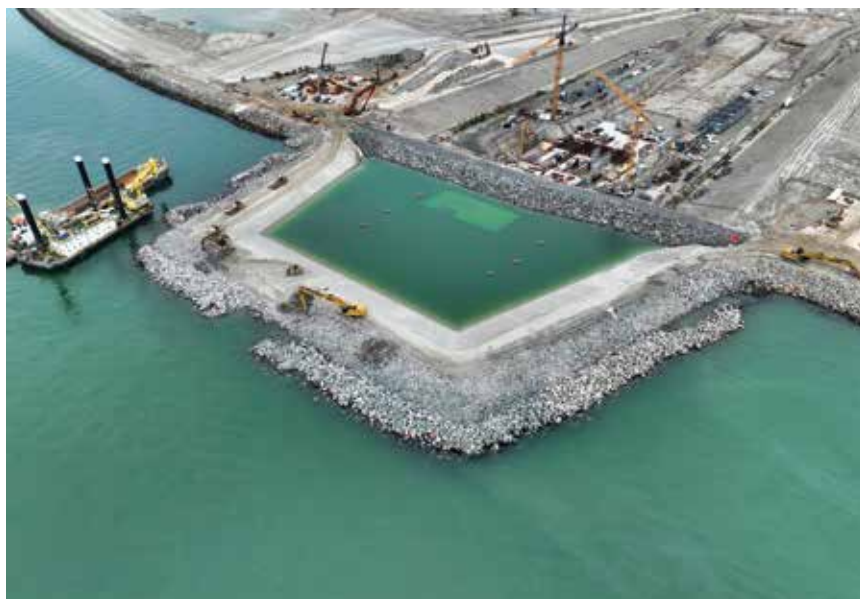
Gradilište portala tunela na danskoj strani, snimljeno u travnju 2024.
