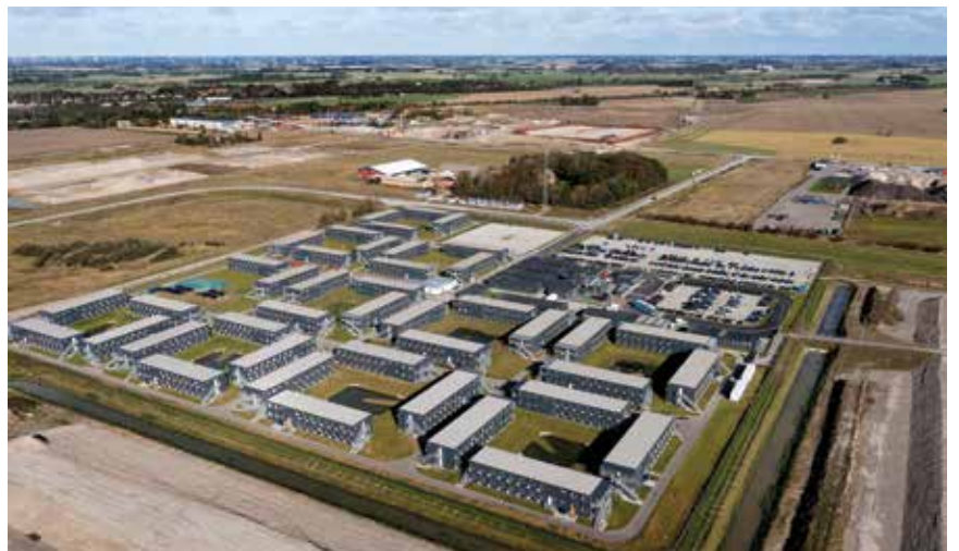
Pogled na stambeni kompleks za radnike na gradilištu
