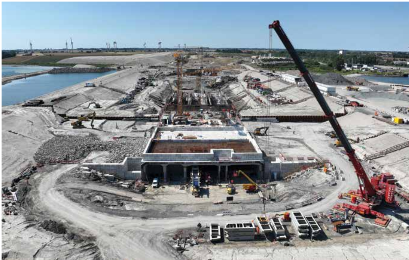
Gradilište portala tunela na njemačkoj strani, snimljeno u lipnju 2024.
